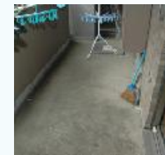
ベランダの排水口
